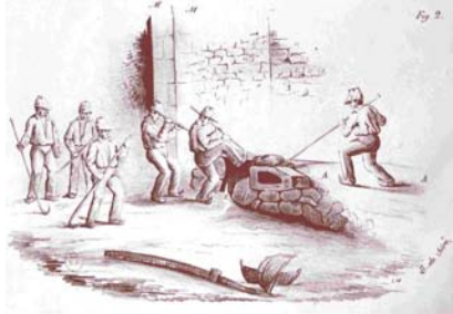
"Extreure el masser... treballar la massoca... estirar la barra" (T. Richard, 1848)
