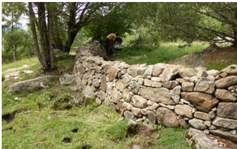
Entretien de mur de pierre sèche (observée durant la visite)
