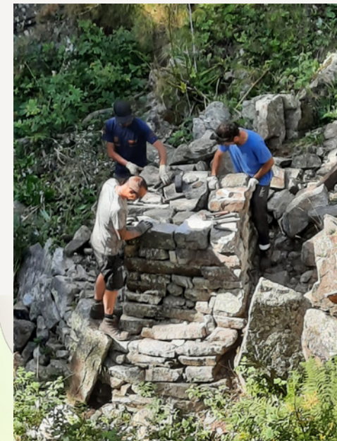
Consolidació del pilar del canal d'alimentació de la ferreria (2024)
