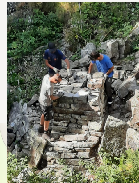
Consolidation de la base du canal d'alimentation de la forge (2024)
