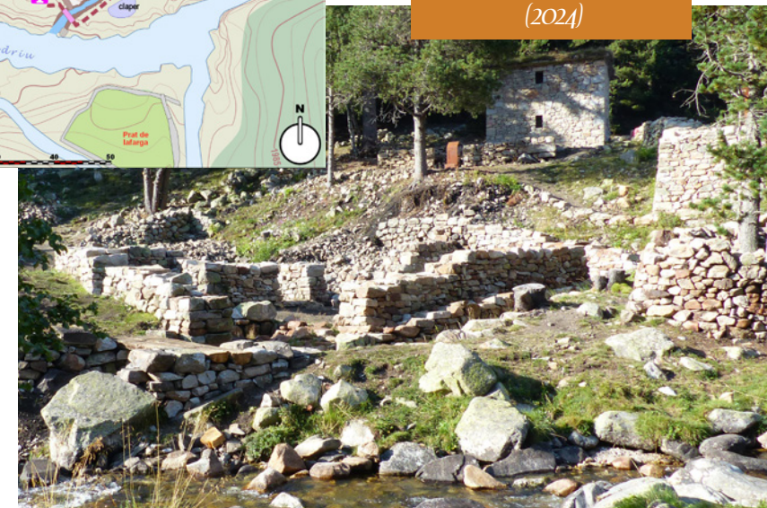
Restauration des structures archéologiques de la forge (2024)
